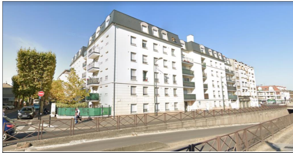
Résidence déjà réalisée sur l'îlot Jaurès / Pasteur / Berteaux
