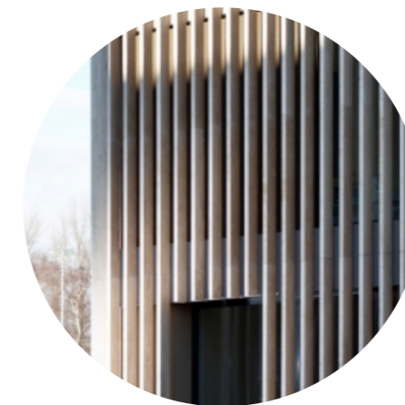
Aspect vertical du parement en pierre (entrée Auchan)
