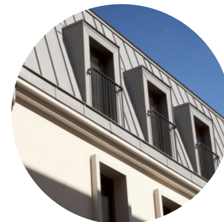
Revêtement de toiture et lucarne en zinc, teinte grise
