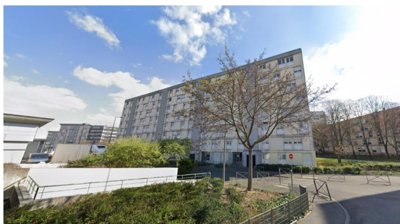
Barre de logements B12 (18 à 24 rue Martin Luther King / 5 à 9 rue Maurice Audin)
