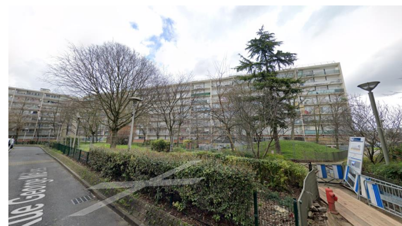
Barre de logements B2
