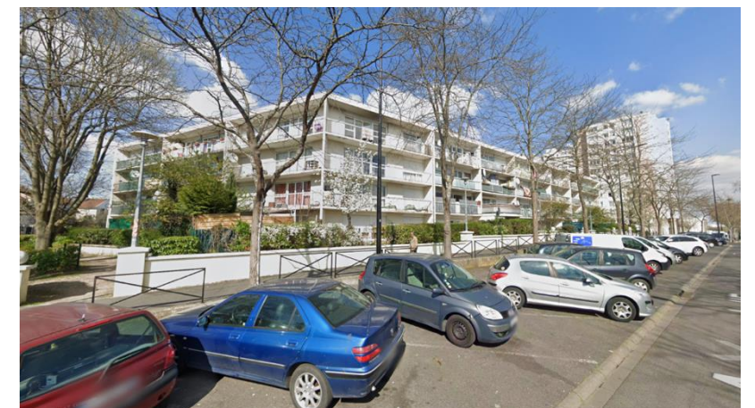
Barre de logements B9 (4 rue Charles Péguy / 6-10 avenue de l'Europe)
