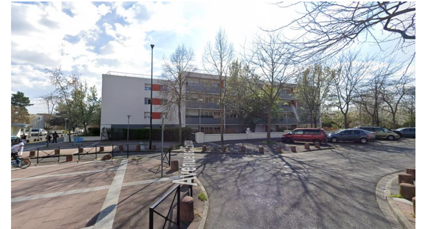
Immeuble de logements collectifs sous forme de barre près de l'avenue de l'Europe
