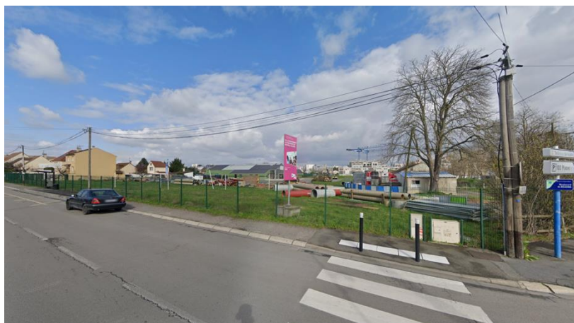
Site de l'entreprise de BTP depuis le Boulevard de Bezons
