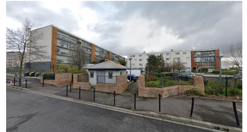
Barre de logements B7
