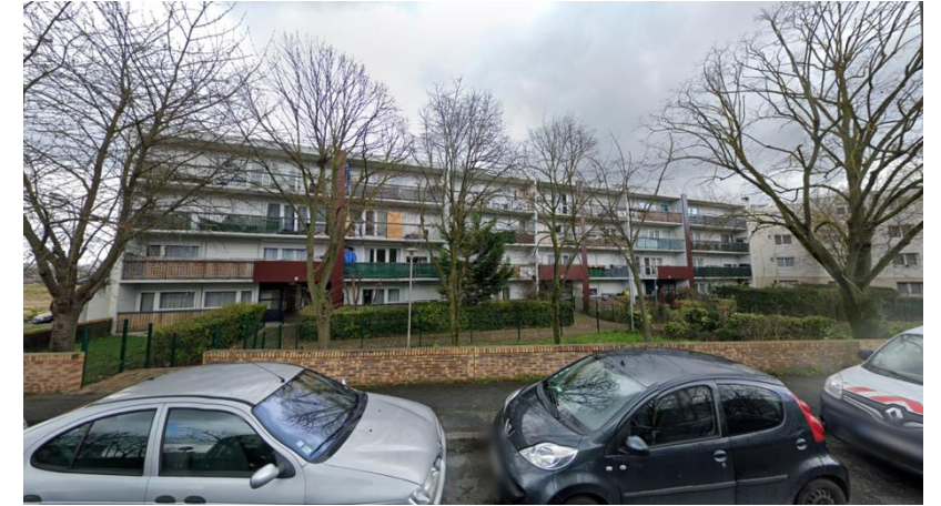
Barre de logements B5
