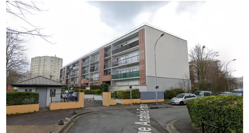
Barre de logements B6
