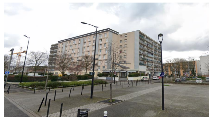
Barre de logements B1
