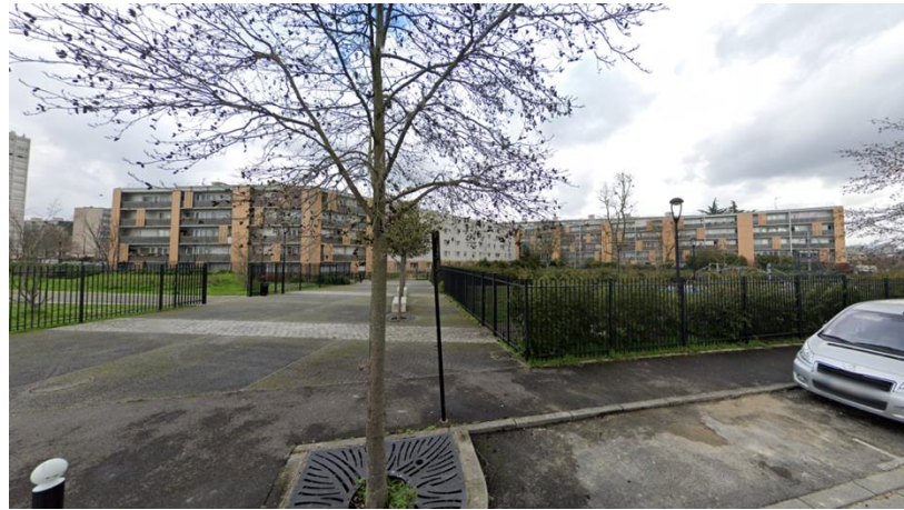
Barre de logements B3
