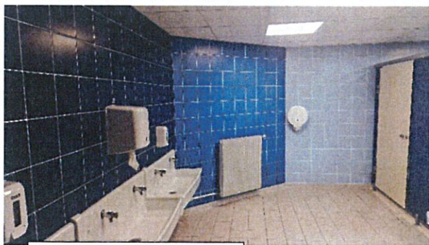
EE Léo Laranée – Réfection des sanitaires
