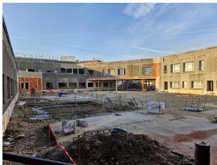
Cité scolaire, travaux cour maternelle
